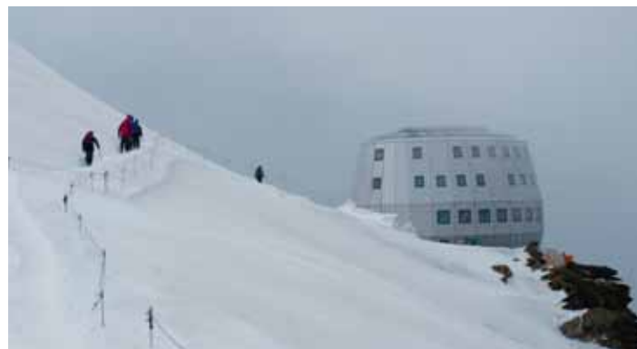
Six conseillers régionaux EELV sont montés en cordée pour visiter le chantier.
